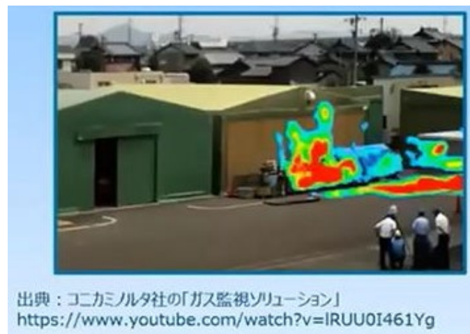
特殊赤外線カメラが捉えた可燃性ガスの漏洩状況
